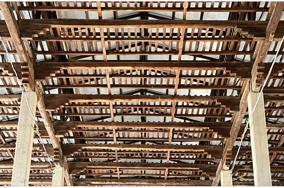
Tipologia costruttiva del graticcio di essiccazione tipico di tutti i tabacchifici della piana del Sele.
