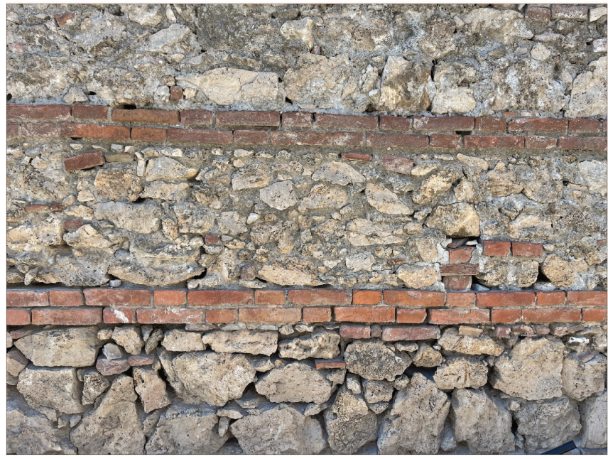
Particolare della tessitura muraria della recinzione perimetrale al "Tabacchificio Cafasso"
