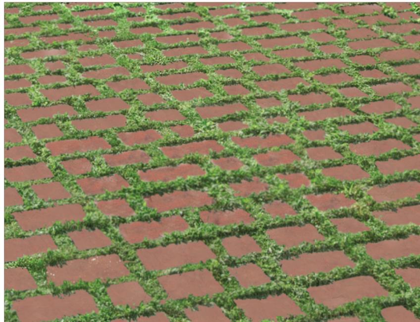
Tipologia di pavimentazione drenante in progetto
